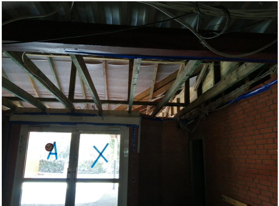
Blick vom ehemaligen Herren-WC zum E-Raum mit provisorischem Wasseranschluss für das Vereinsheim
